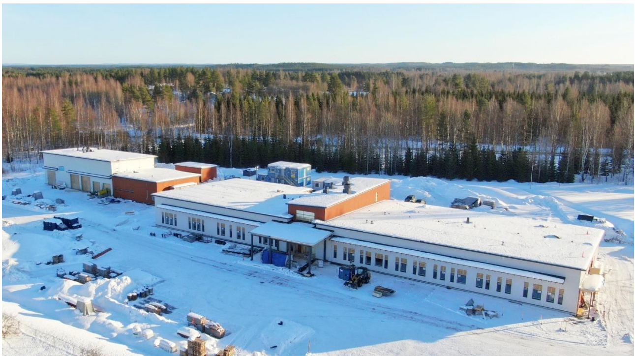
Rakenteilla oleva sote-asema
