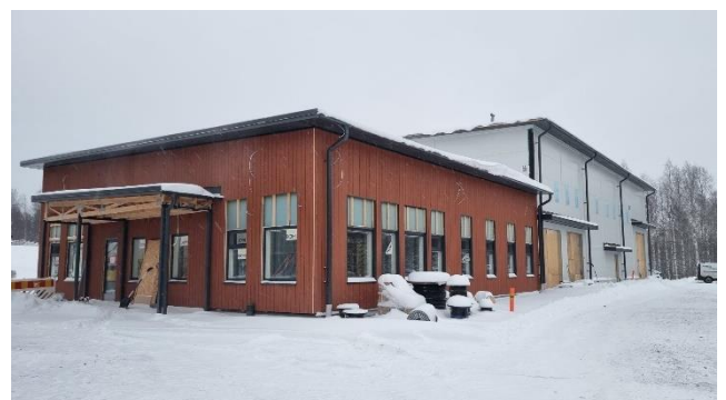
Rakenteilla oleva pelastusasema
