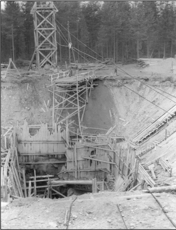
Kuva 25. Kuva Keretin kaivostornin rakenteiden rakennusvaiheesta. Kuva: Outokummun kaivosmuseo.
