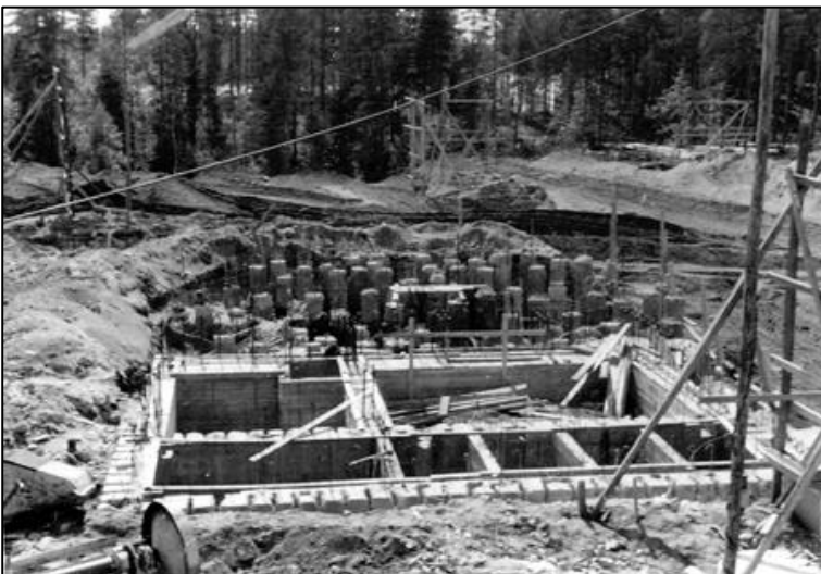
Kuva 24. Kuva Keretin kaivostornin rakenteiden rakennusvaiheesta. Kuva: Outokumpun kaivosmuseo.
