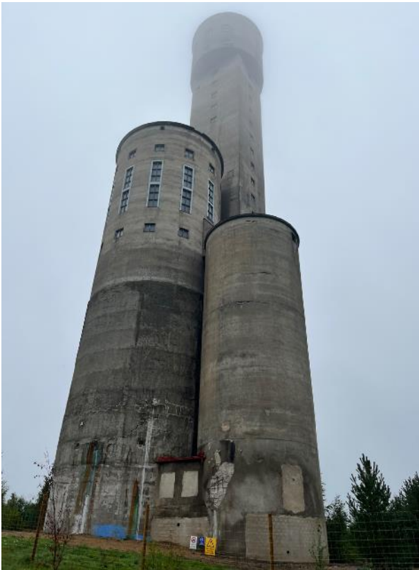
Kuva 3. Keretin kaivostorni kuvattuna syyskuussa 2023.
