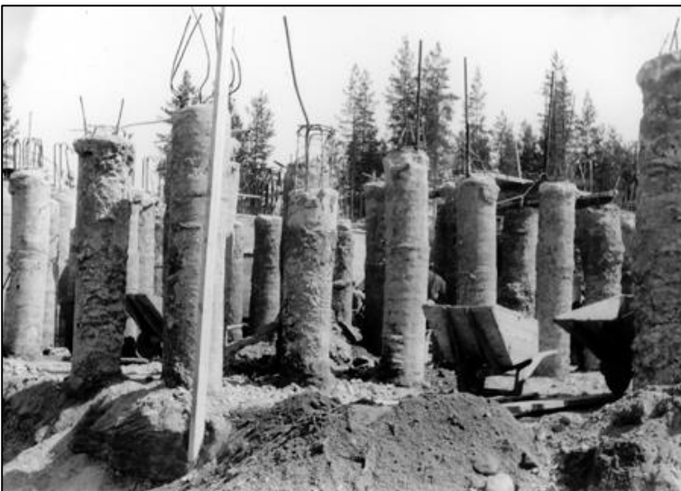
Kuva 26. Kuva Keretin kaivostornin rakenteiden rakennusvaiheesta. Kuva: Outokummun kaivosmuseo.
