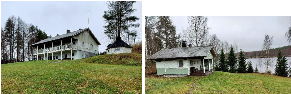
Kuva 12. Korttelin 1, rakennuspaikan 1 rakennuksia. Kuvat: Heli Jokela, FCG
