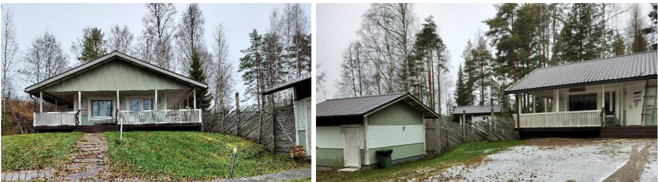
Kuva 9. Korttelin 1, rakennuspaikan 4 rakennuksia. Kuvat: Heli Jokela, FCG
