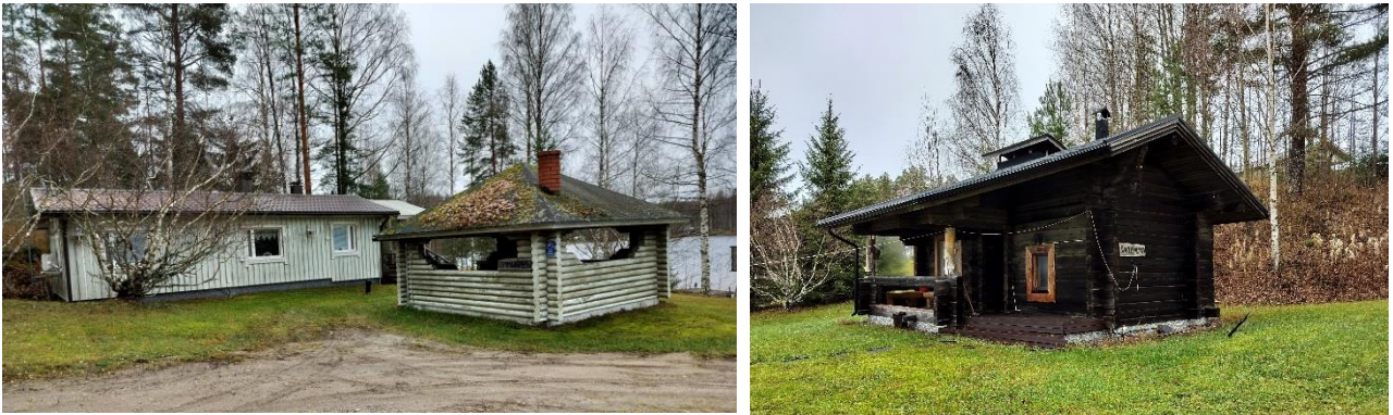
Kuva 11. Korttelin 1, rakennuspaikan 2 rakennuksia. Kuvat: Heli Jokela, FCG
